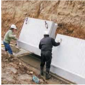
ブロック据付
