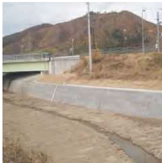
護岸ブロック据付完了
