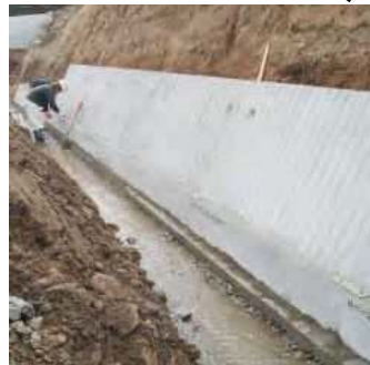
ブロック据付完了
