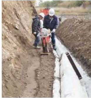
裏込め砕石投入
